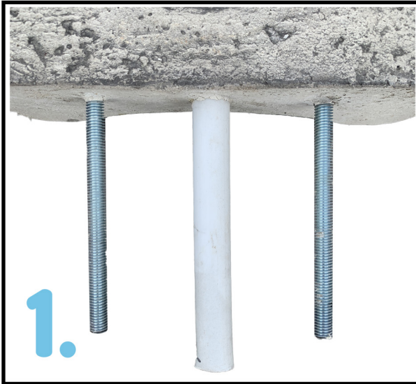
Állókutak – víz bekötés előkészítés
